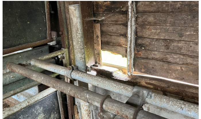
Afbeelding 8. Diverse openingen in de aanpalende schuur
