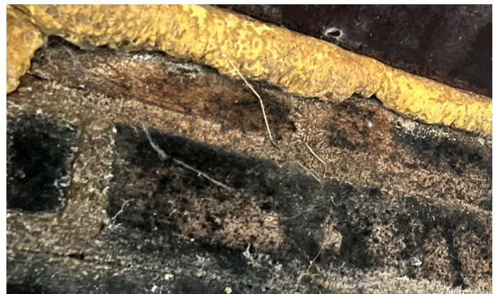
Afbeelding 10. Randen zijn bekleed met pur (aangebracht voordat de huidige eigenaren het perceel kocht)
